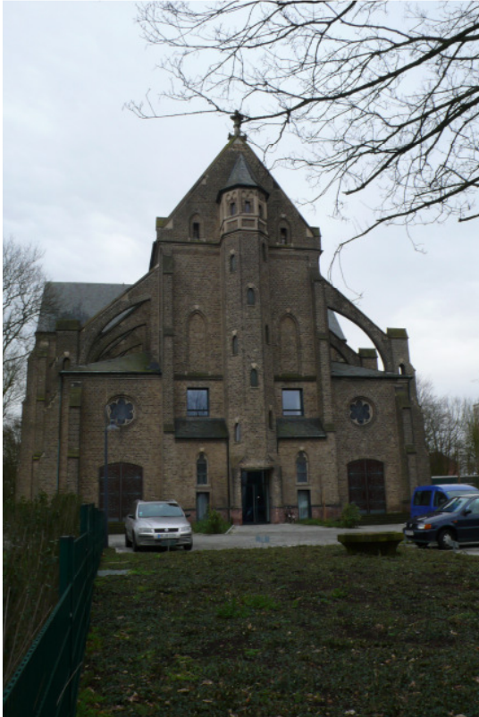
Die umgebaute Herz-Jesu-Kirche in Mönchengladbach-Pesch mit 23 öffentlich geförderten Wohnungen
