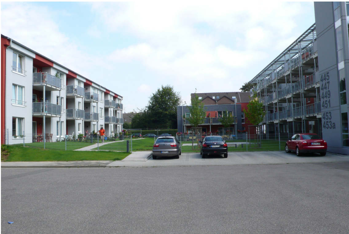
Die modernisierte und erweiterte Siedlung in Mönchengladbach-Eicken
